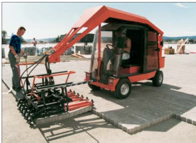
Maskinnedlægning af belægningssten - hurtigt og effektivt.
